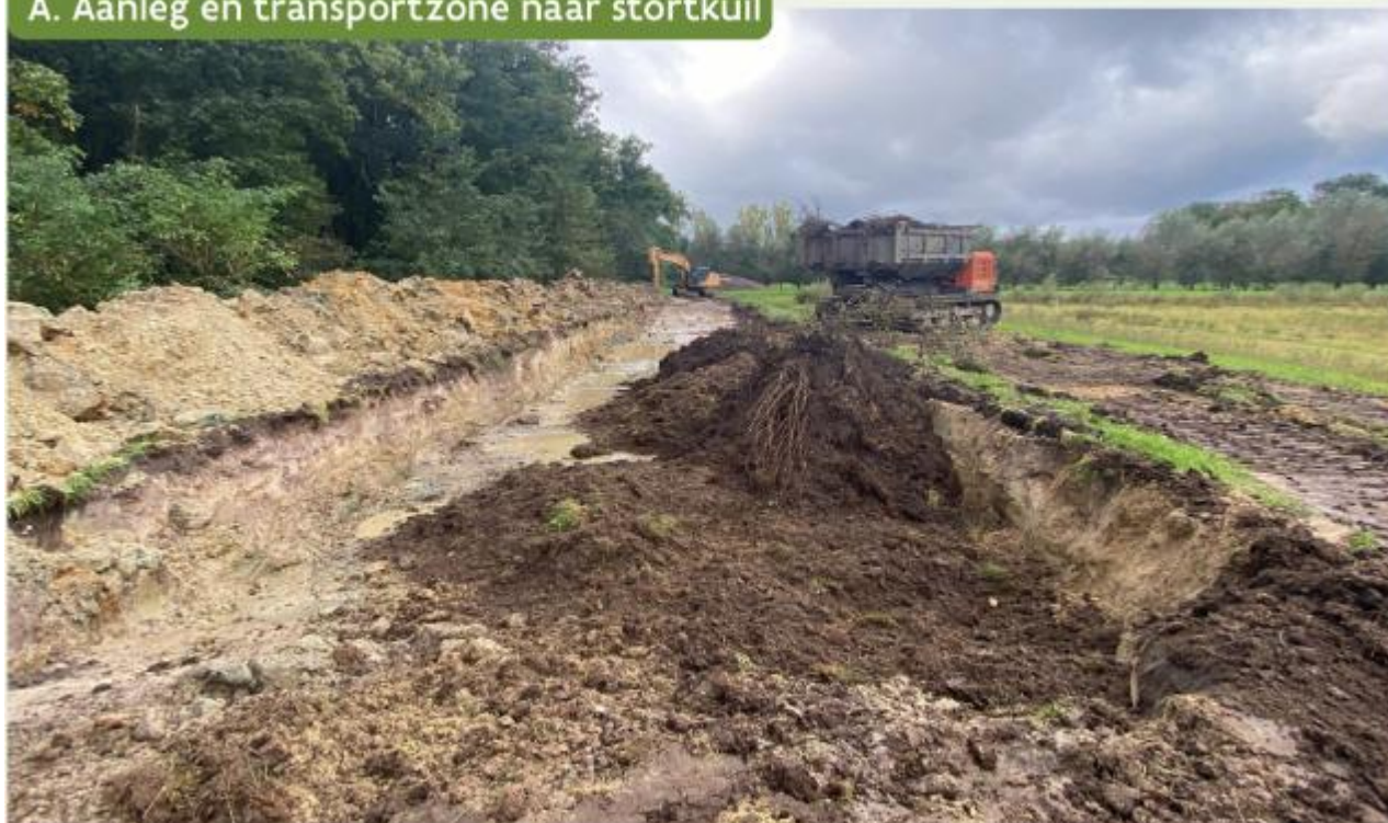
Aanleg stortkuil als sleuf (najaar 2024)
