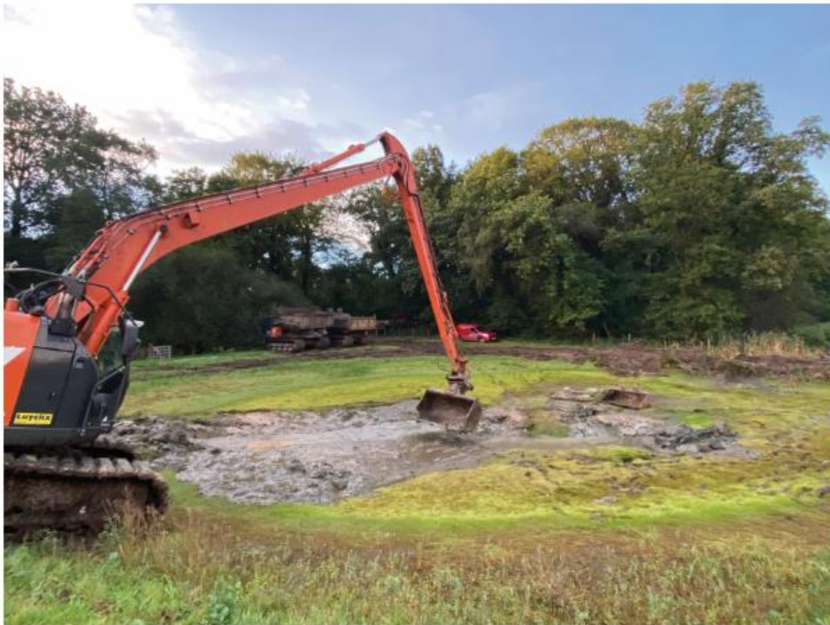
Ongewenst effect bij afgraven watercrassula: waterverzadigde zandige pap spoelt af naar de lagere zone.
